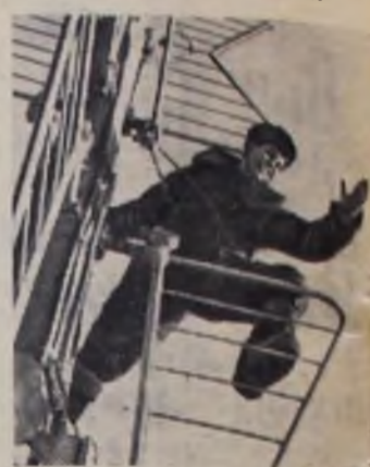
КАМЧАТСКАЯ ОБЛАСТЬ. Закончен монтаж самой восточной в стране телевизионной мачты в Петропавловске-Камчатском.
