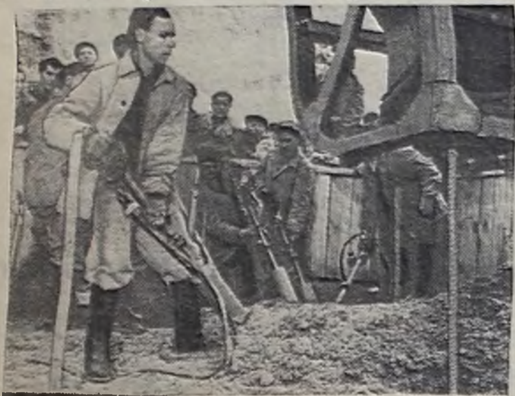
Красноярский край. Строители крупнейшей в мире Красноярской ГЭС ведут укладку первого бетона в тело плотины ГЭС. Фото Ю. Бармина. Фотохроника ТАСС.
